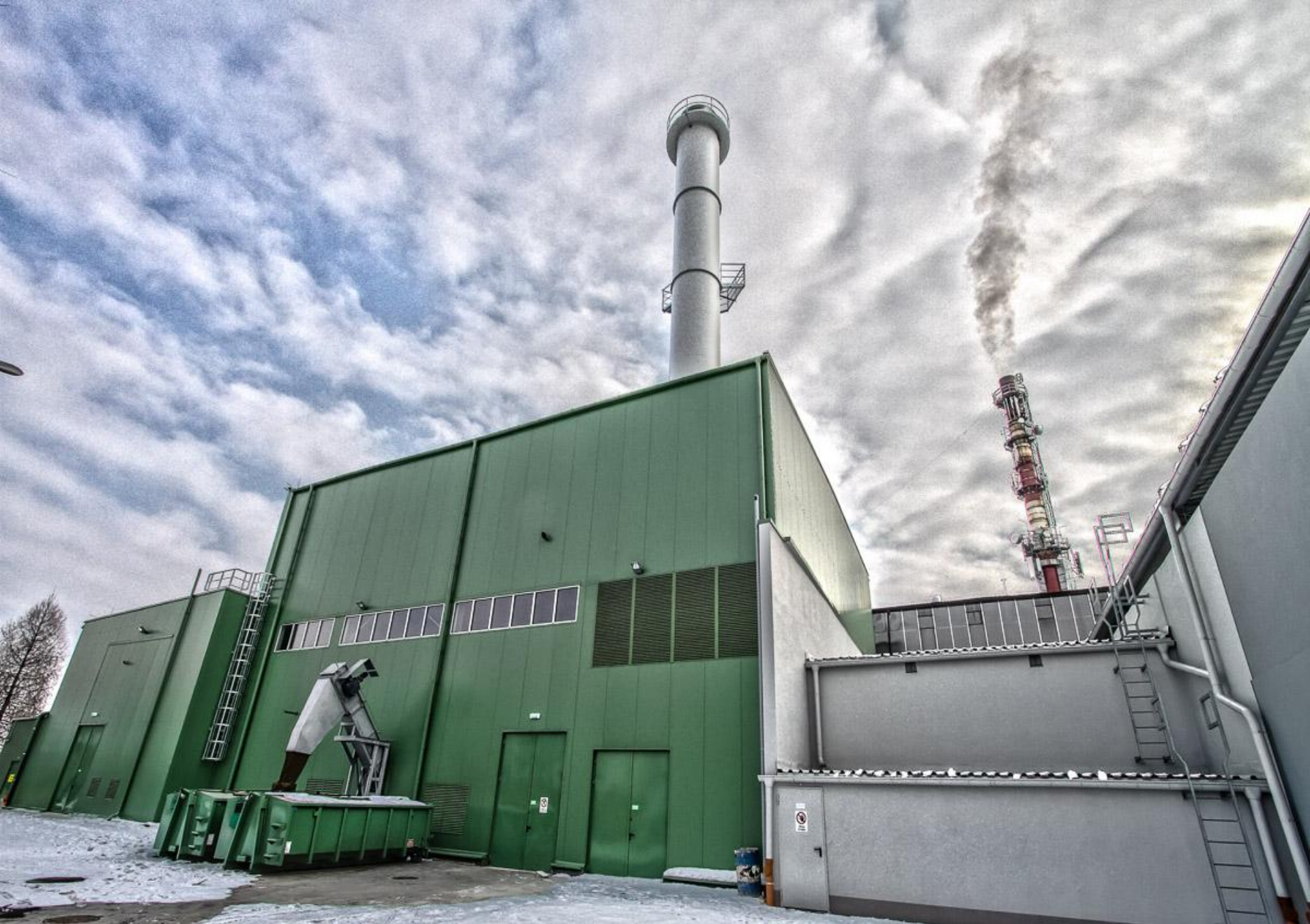
Budynek Elektrociepłowni - ORC
